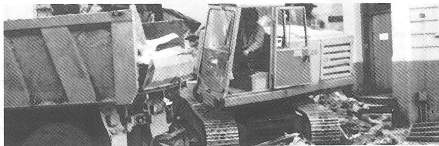
Da et hus som i mange år skjulte Nonneseter kapell — omsider ble revet, ble kirken litt mer synlig.
