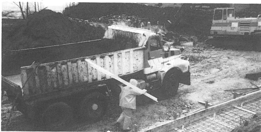
Entreprenør Terje Larsen A/S har begynt arbeidet i Kalfarvei 77 -bildene er tatt like over nyttår 1989.
